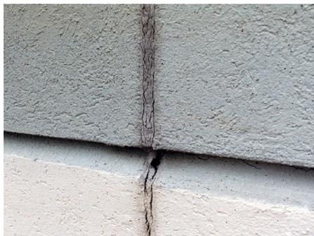
Поверхность полиуретанового герметика морщится
